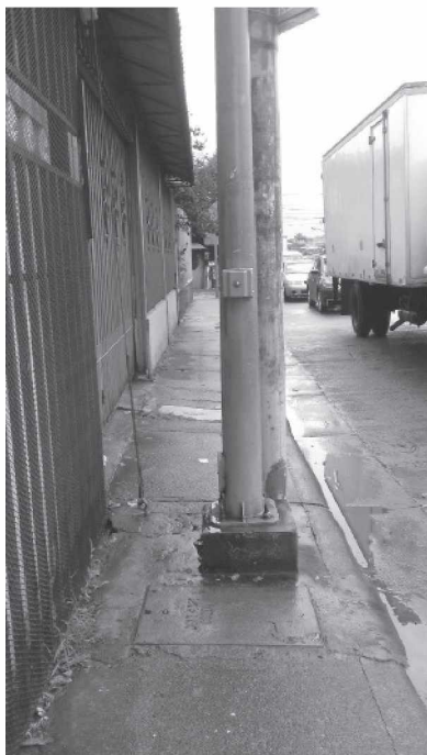
Figura 3. Acera en San José, presenta el poste del semáforo peatonal y un poste de alumbrado público, así como un tensor metálico colocado cerca de los mismos, todos obstruyen el paso. Nota. Elaboración propia.
