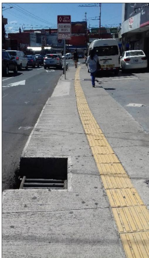
**Imagen 5.** Carretera Interamericana, San Pedro de Montes de Oca, San José. Se muestra una acera con baldosa táctil, en la que destaca un desnivel sobre la tapa de un drenaje, que genera una discontinuidad y peligro para el tránsito peatonal. Autora: Laura Paniagua Arguedas, 2018.
