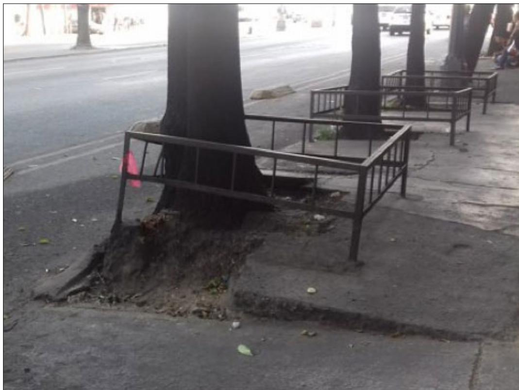
**Imagen 7.** Avenida Revolución, Ciudad de México. Se muestra una acera levantada por las raíces de un árbol, adicionalmente se percibe una estructura de metal que obstaculiza el paso, que rodea al árbol y le sirvió como protección. Autora: Laura Paniagua Arguedas, 2018.
