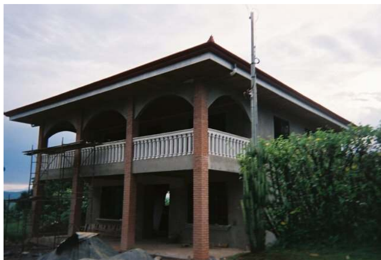
Casa en construcción en Pérez Zeledón
