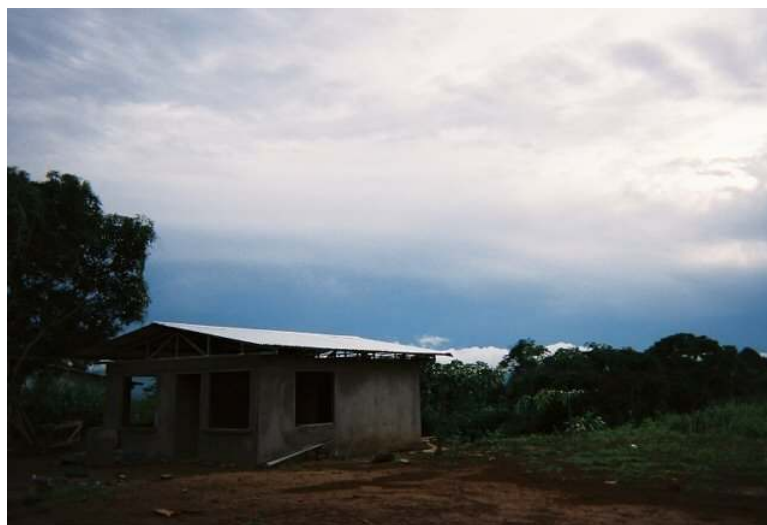
Casa en construcción en Pérez Zeledón
